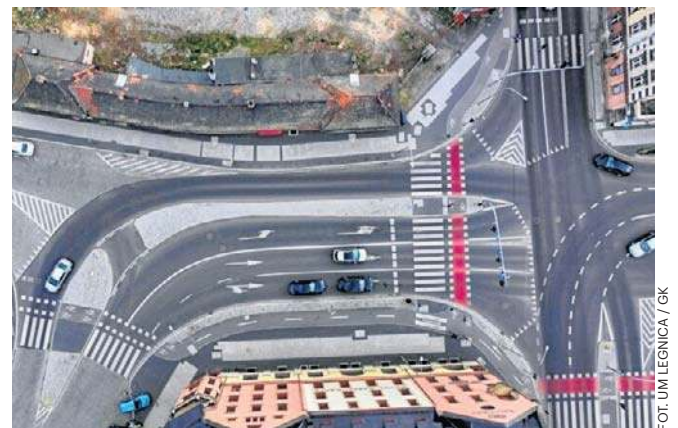
Zmieni się organizacja ruchu przy legnickim dworcu PKP. Powodem są prace przy centrum przesiadkowym
