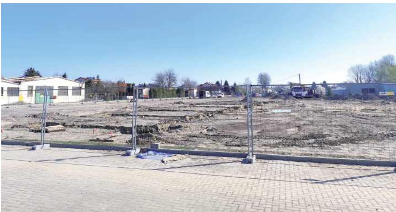
Plac zostanie utwardzony, powstaną również dwie wiaty
