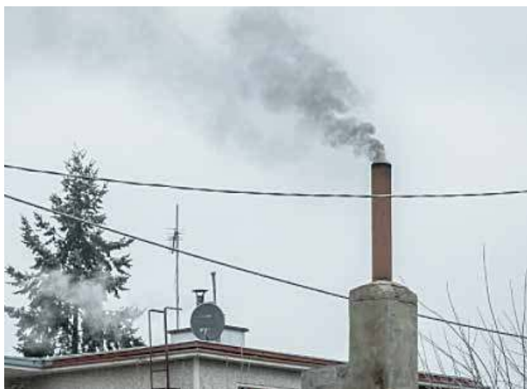
Kolejnych siedem pieców będzie mogło zostać wymienionych na bardziej ekologiczne m.in. dzięki udzielonym dotacjom
