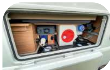
Schowek all in – w jednym miejscu zawory do tankowania i opróżniania zbiorników, a także gniazdo do podłączenia zewnętrznego źródła prądu
