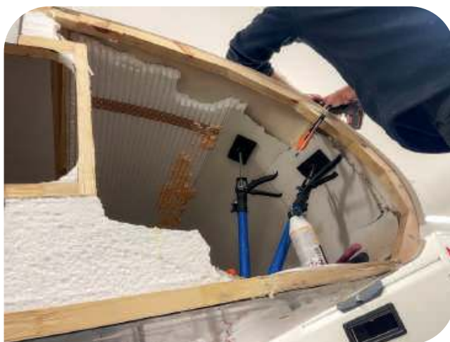
Naprawa ściany bocznej w alkowie to jedna z tych, którą w taki dokładny sposób wykonacie tylko w Mościskach. Mowa o tapicerowaniu panelu ściany od wewnątrz, dzięki czemu wewnątrz będzie dużo przytulniej
