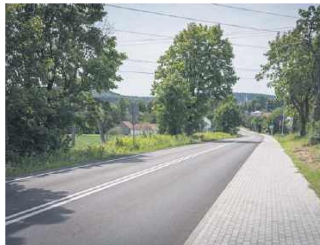
Droga Wojnicz–Więckowice–Wielka Wieś po modernizacji
