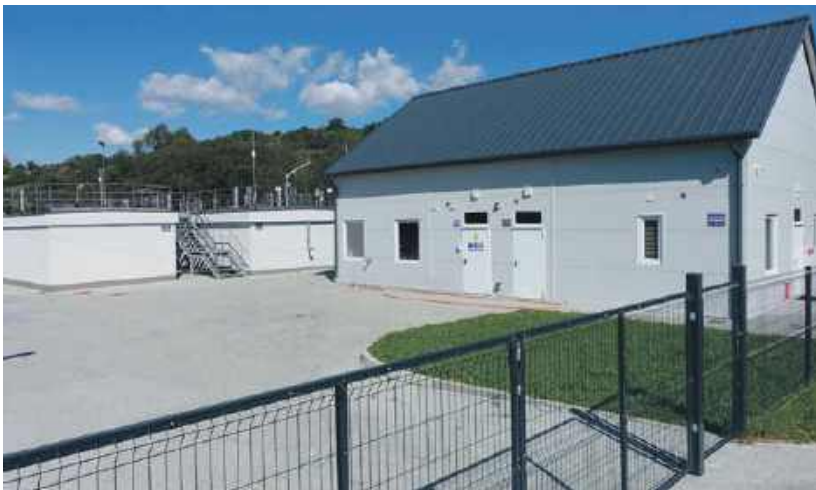
Stacja Uzdatniania wody
