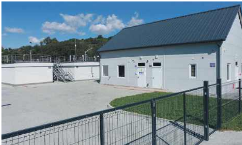
Stacja Uzdatniania wody
