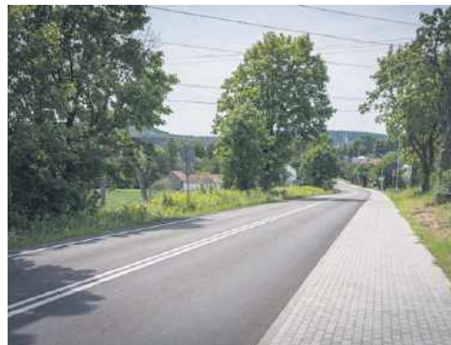
Droga Wojnicz-Więckowice-Wielka Wieś po modernizacji
