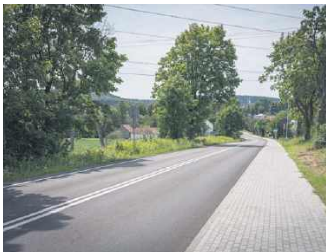
Droga Wojnicz–Więckowice–Wielka Wieś po modernizacji
