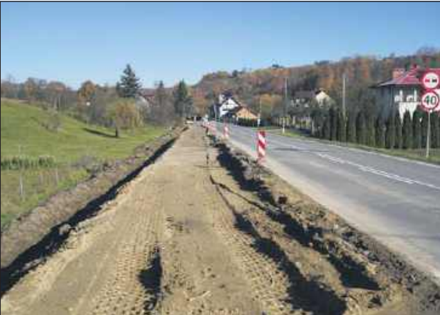
Kontynuowana jest rozpoczęta w ubiegłym roku budowa asfaltowej ścieżki rowerowej przy DW nr 975 w miejscowościach Bieśnik, Zdonia Borowa i Paleśnica aż do granicy z gminą Gródek nad Dunajcem
