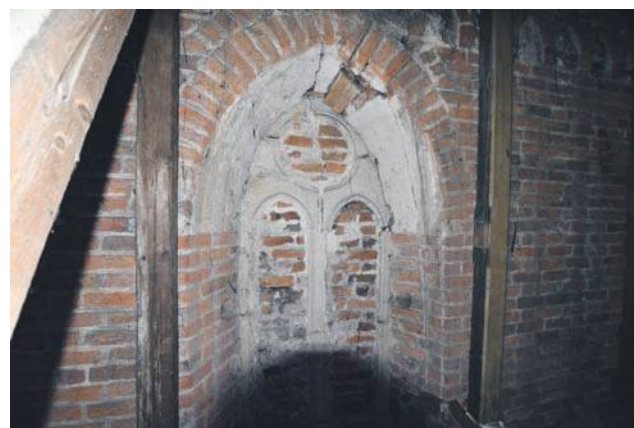
Zamurowane okno prezbiterium, ukryte na poddaszu zakrystii
