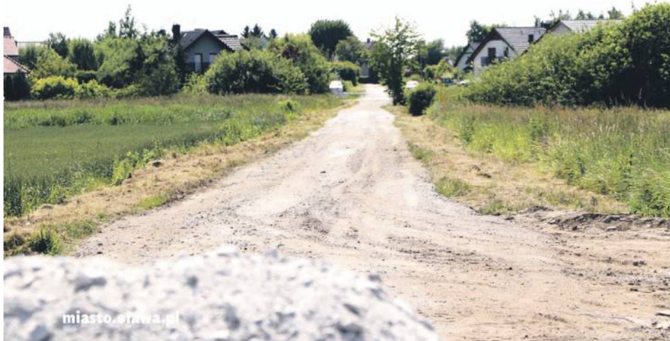
Na tym odcinku będzie asfalt - ulica Brylantowa
