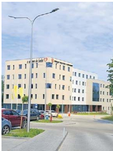
Nowy budynek przy ul. Wiewiórczej jest już gotowy
