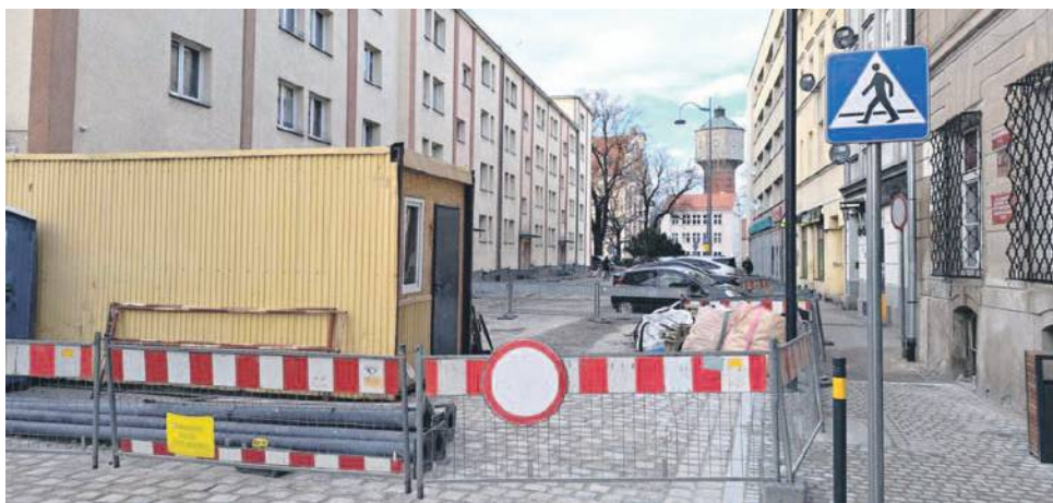
Krótka przygotowana do remontu
