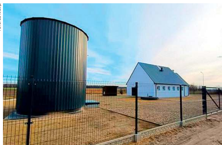
Zakończyła się rozbudowa hydroforni w Szczepkowie
