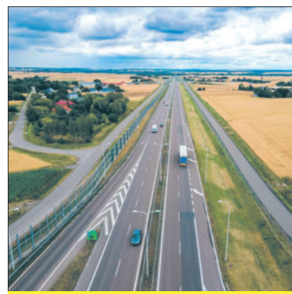
Remont obejmie trasę S12/S17 łączącą obwodnicę Lublina z obwodnicą Piask.
