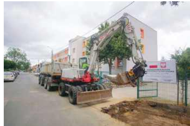
Trwają prace związane z remontem chodnika przy ul. Sienkiewicza w Strzelinie. Fot. UMiG Strzelin
