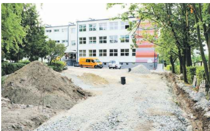
Wymiana nawierzchni przed SP nr 6
