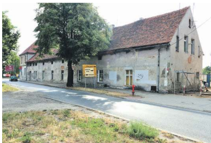
Ruszył remont budynku przy Lipowej 20
