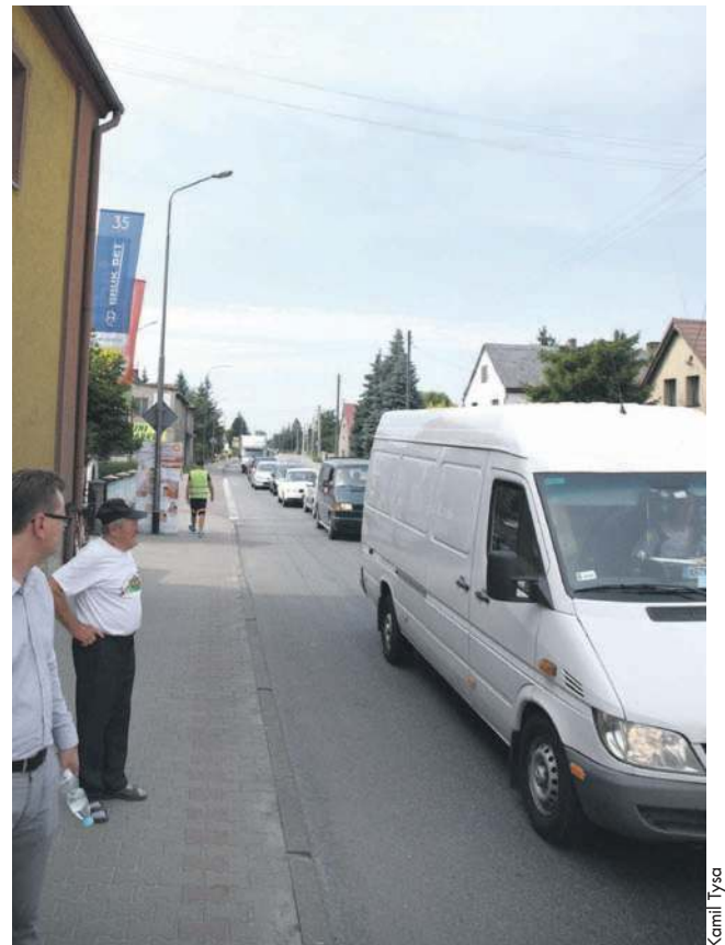
Odcinek od ulicy Opolskiej do Godzikowic ma być remontowany
