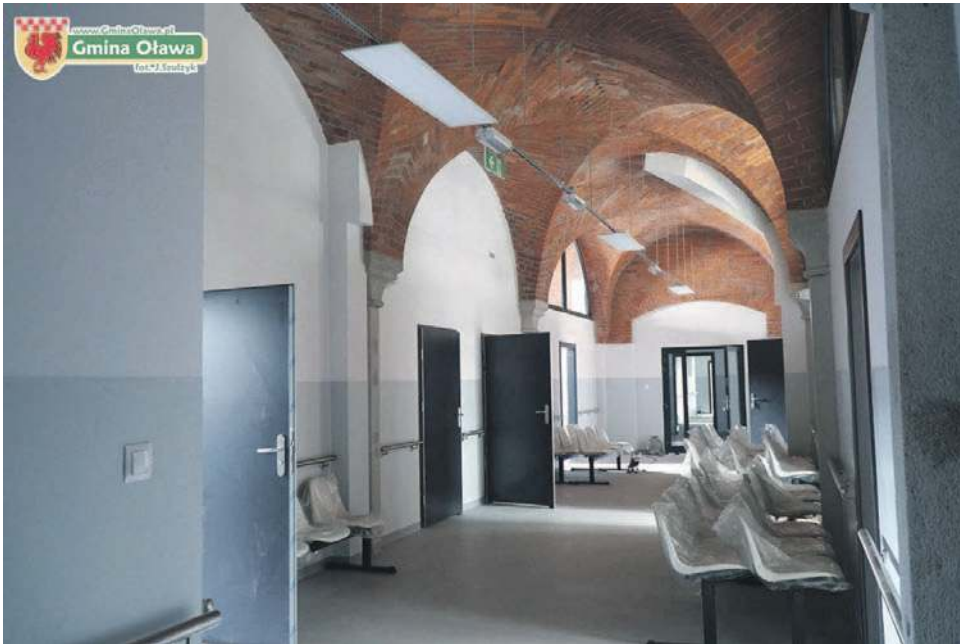
Pozostałe prace wykończeniowe
