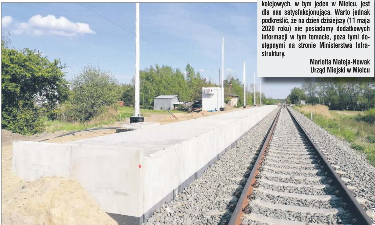
Tak będzie wyglądać nowy przystanek kolejowy na ul. Witosa w Mielcu.
