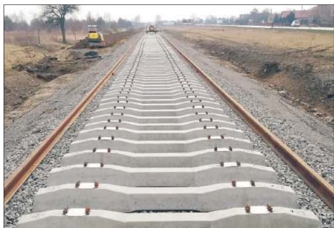
Tak wygląda budowa nowych torów na wysokości gminy Przecław.
