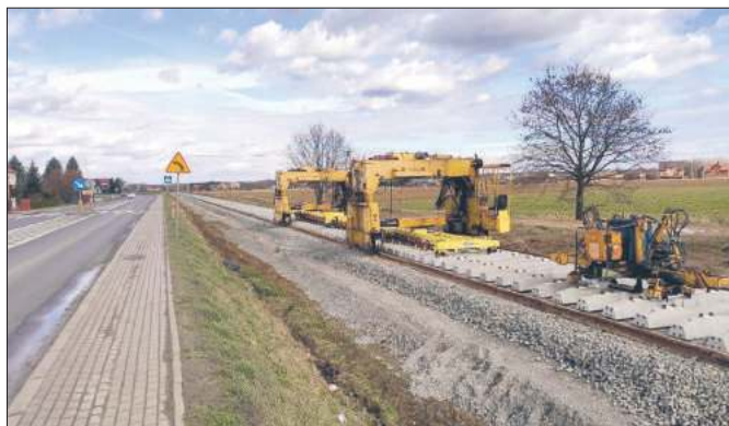
Rzemień, budowa toru na tzw. podsypkach.
