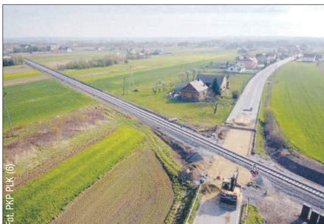
Jeden z wyremontowanych przejazdów kolejowych na terenie Pustkowa.
