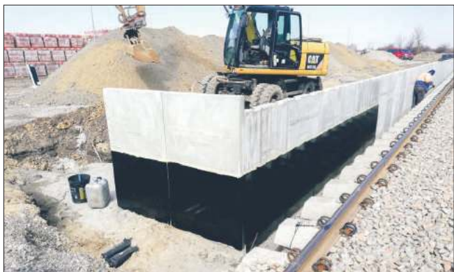
Tak wygląda budowa jednego z przystanków kolejowych.
