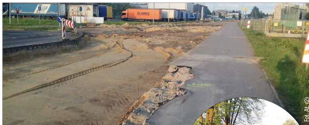
Remont ulicy Wojska Polskiego od strony ulicy Padykuły.
