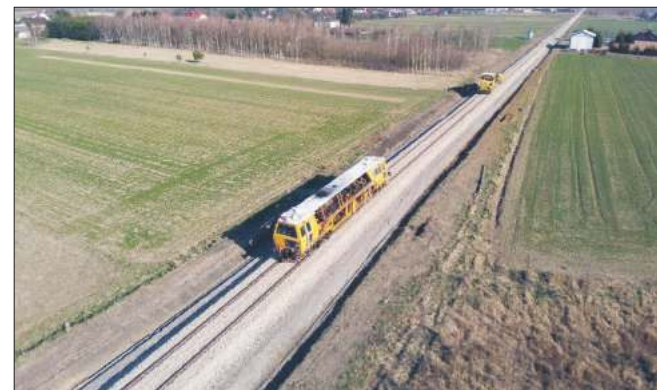
Budowa tzw. podsypki pod tory na terenie gm. Przecław.
