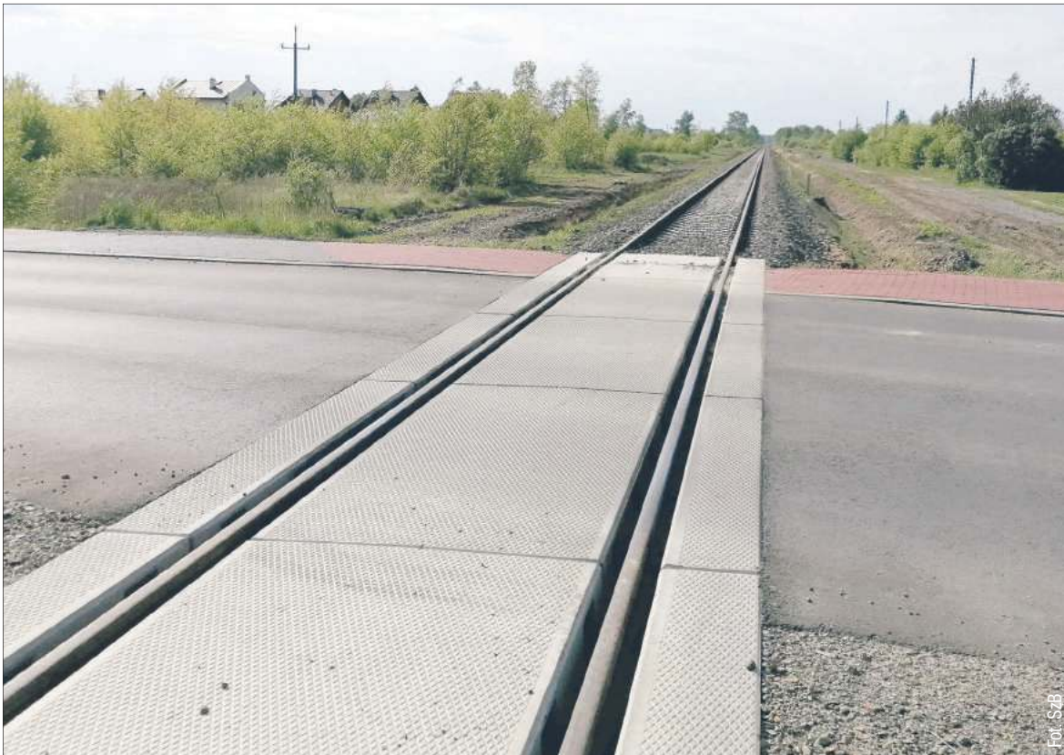
Jedno z przebudowanych przejazdów kolejowych na ul. Witosa w Mielcu. Robotnicy zamontowali już nowe tory w całym mieście. Teraz inwestycja przeniosła się na teren gminy Przecław.
