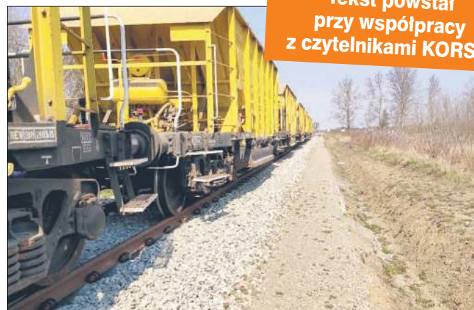
Rzemień, tzw. balastowanie toru.
