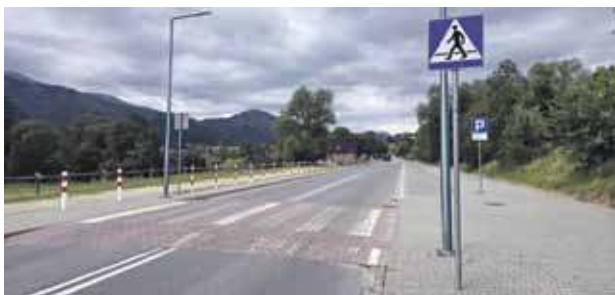
Policja przyznaje, że progów jest dużo, ale odkąd je zamontowano, nie było żadnego zdarzenia drogowego na tym odcinku ulicy.
