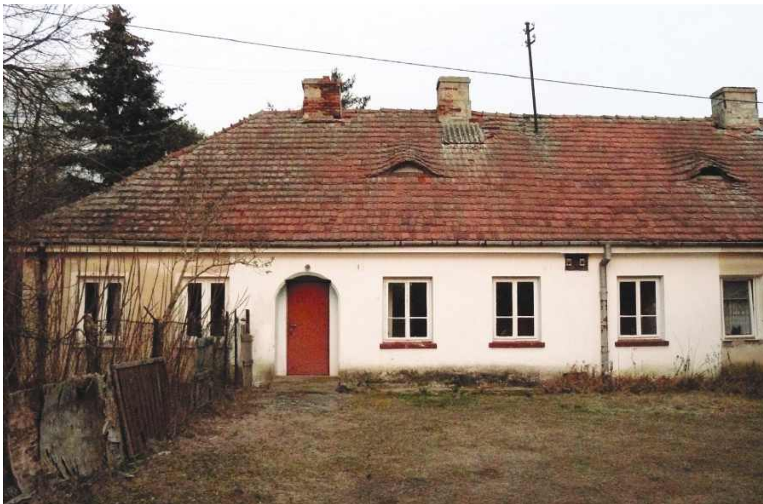
Zabytkowa oficyna przy ruinach pałacu
