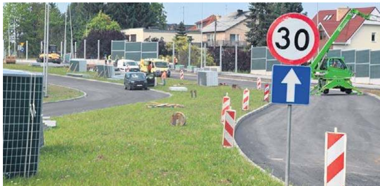
Termin zakończenia budowy pierwszego odcinka to 30 września
