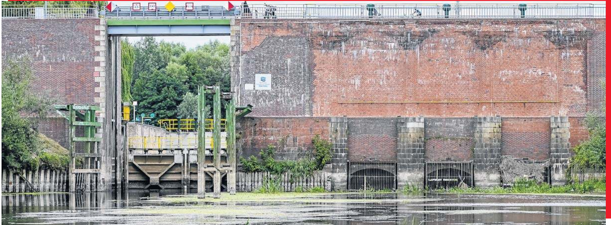
Stopień wodny w Białej Górze to śluza z wrotami przeciwpowodziowymi i jaz z przepławką dla ryb.
