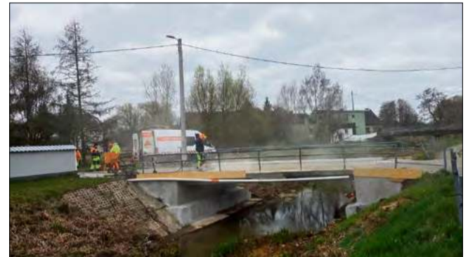
Prace idą pełną parą.
