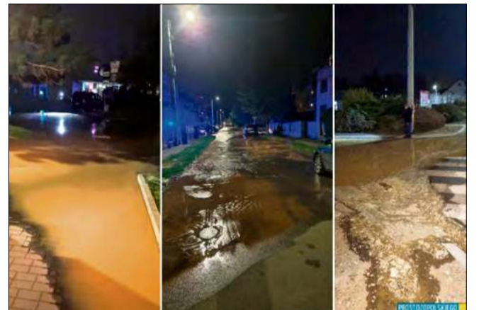
W Krapkowicach przy ulicy Słowackiego doszło do uszkodzenia sieci wodociągowej.
