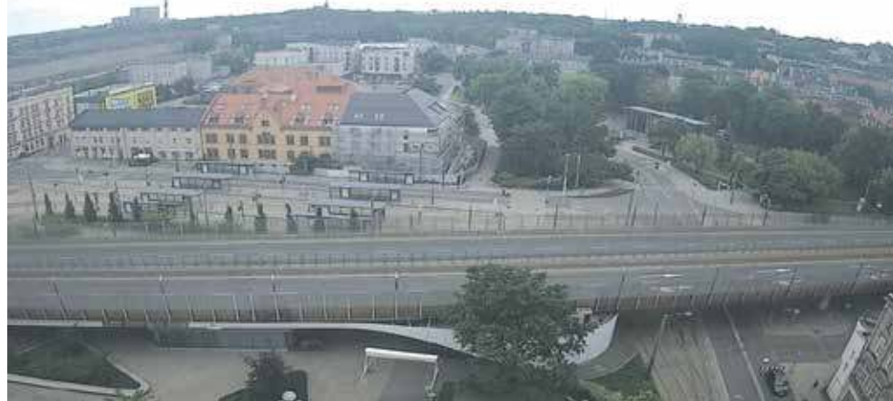
Opustoszała estakada w Chorzowie
