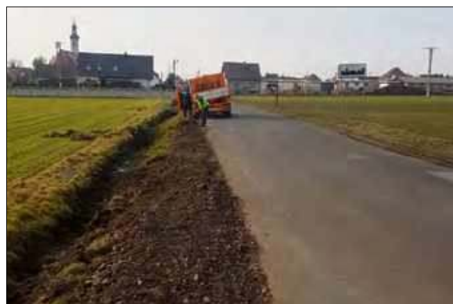
Uszkodzone pobocze drogi powiatowej nr 1833 w Raławiczkach zostało naprawione.
