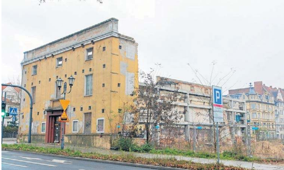
Przy ul. Warszawskiej powstanie nowa siedziba Teatru Muzycznego w Toruniu
