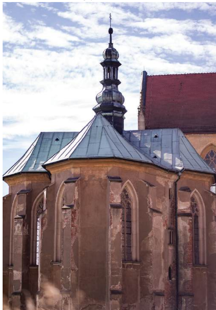
Kaplica książęca przy kościele klasztornym z zewnątrz.
