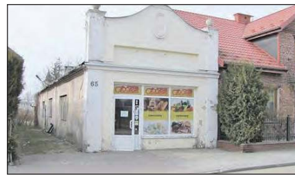
>> Widok budynku handlowego ul. Nowa 65 (pkt. I.2 ogłoszenia)
