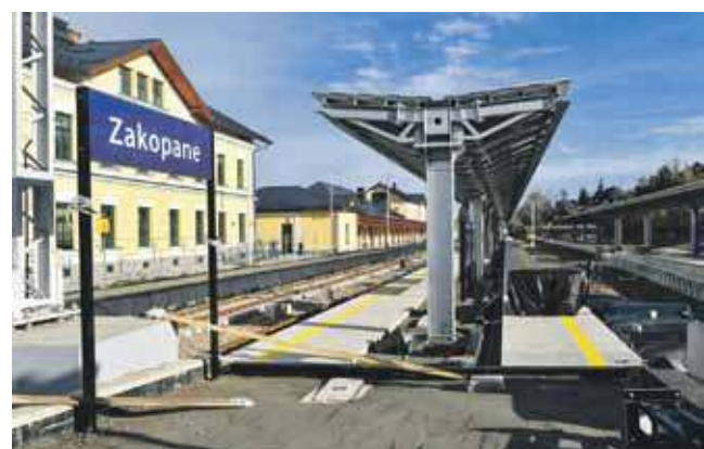
Coraz bliżej do zakończenia remontu dworca kolejowego w Zakopanem. Do całego centrum komunikacyjnego ma prowadzić nowa droga od ronda na Spyrkówce.
