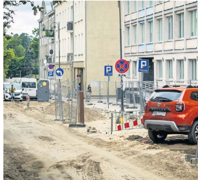
Ulica Marcinkowskiego wciąż jest rozkopana, auta nie mogą wjechać na podwórkę, a sąsiadnie ulice są zapchane i do tego ograniczono liczbę miejsc
