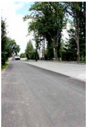
Firma Rebudrog zakończyła przebudowę części drogi wewnętrznej prowadzącej do powstającego kompleksu lekkoatletycznego
