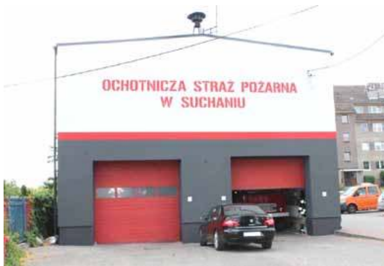
Budynek OSP został ocieplony z zewnątrz a elewacja zyskała nowy kolor
