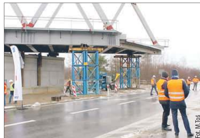
Wiadukt powstaje nad DK9.
