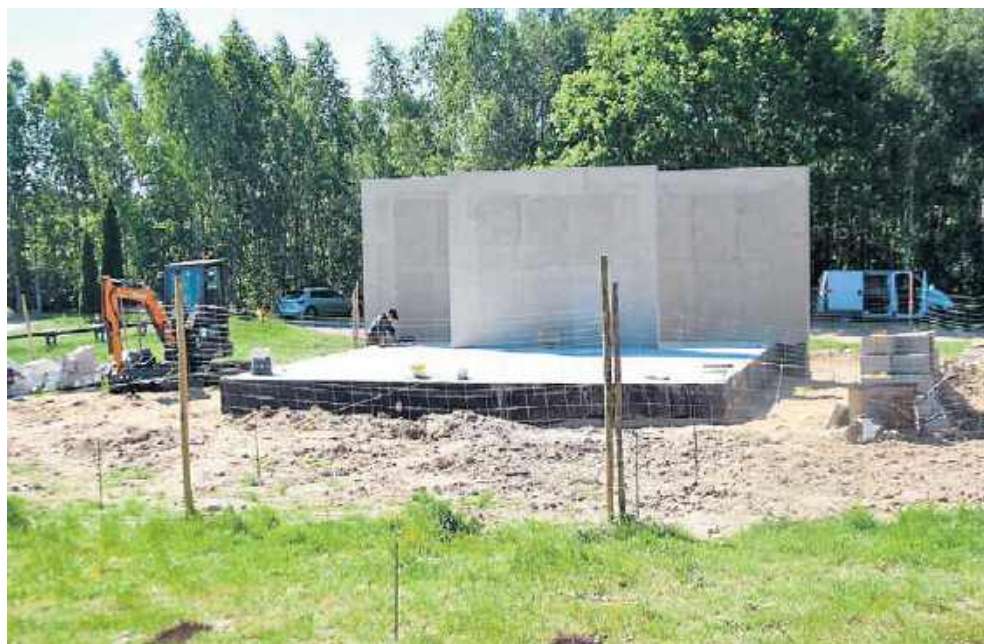
Budowa Leśnego Amfiteatru na Krakowej Górze, to nowa inwestycja mająca na celu stworzenie miejsca spotkań, rekreacji i wydarzeń kulturalnych.
