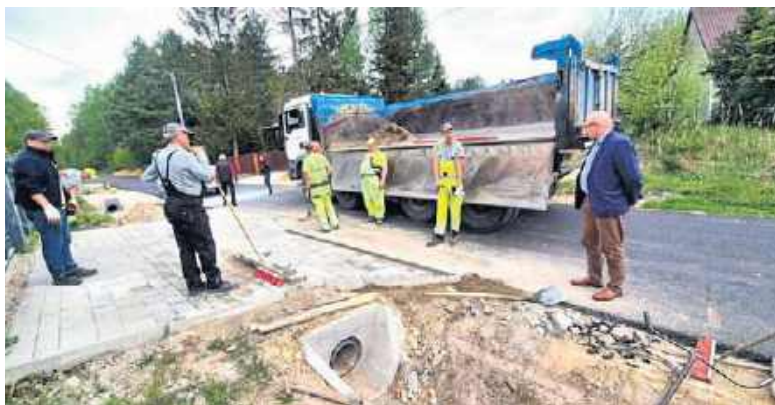
Na miejscu budowy był burmistrz Adam Pałgan (z prawej).
