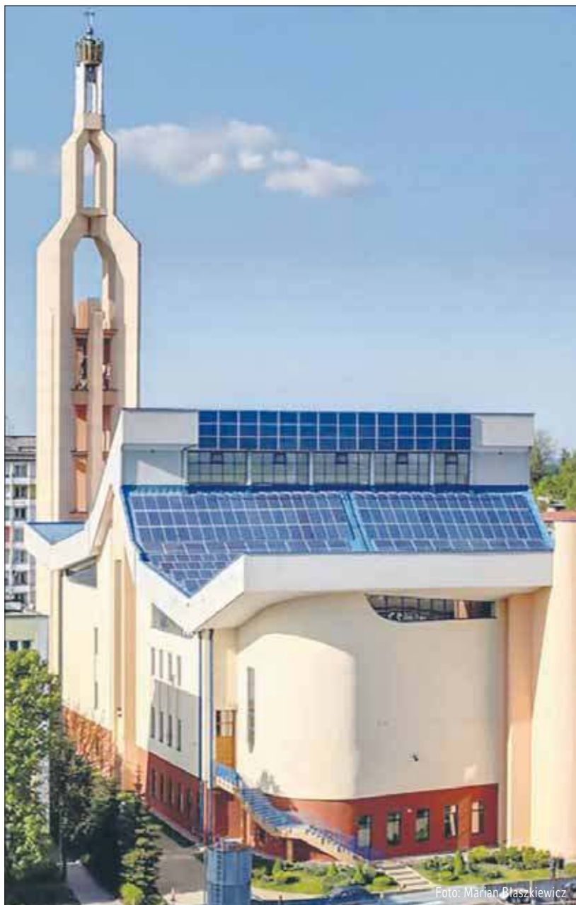
Fotowoltaiczna elektrownia na dachu sanktuarium MBNP
