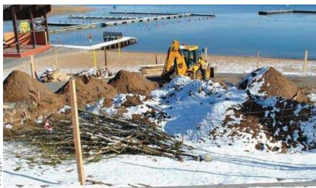
Trwa budowa Miejsca Obsługi Rowerzystów w Wilkasach nad jeziorem Niegocin
