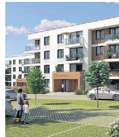
Koniec budowy nowych bloków zaplanowano w 2029 r.
