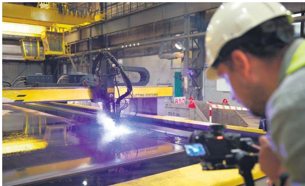
W zakładach Grupy Przemysłowej Baltic w Gdyni i Gdańsku trwa produkcja m.in. stalowych platform do cumowania łodzi serwisowych. Zostaną one zamontowane na każdym z fundamentów turbin wiatrowych farmy Baltica 2. To niezbędne wyposażenie umożliwiające technikom dostęp do wnętrza turbiny.
