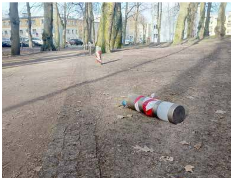
Niektóre z lamp są dosłownie przewrócone
