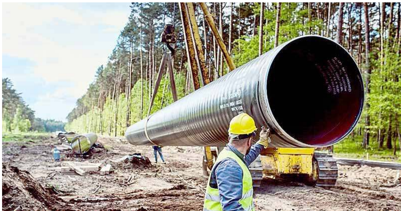
Zakończyła się przebudowa gazociągu Goleniów Police
