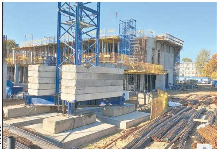
Ponad ogrodzeniem placu budowy jest widocznych coraz więcej elementów konstrukcyjnych
