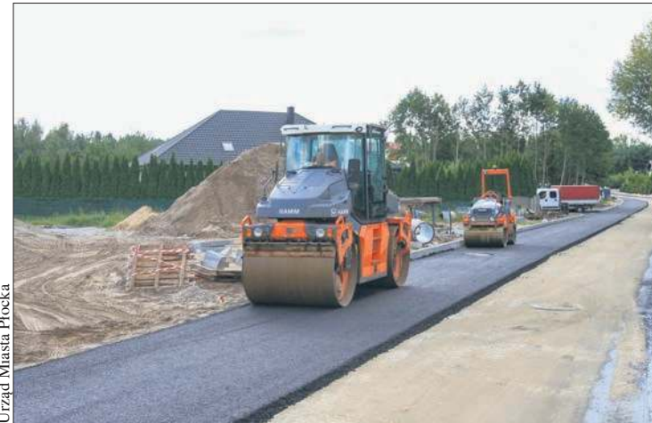
Trwa przebudowa ulicy Browarnej
