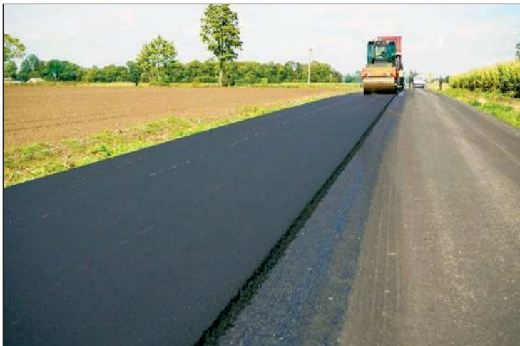
Wylanie nowej nawierzchni to jeden z ostatnich etapów inwestycji
