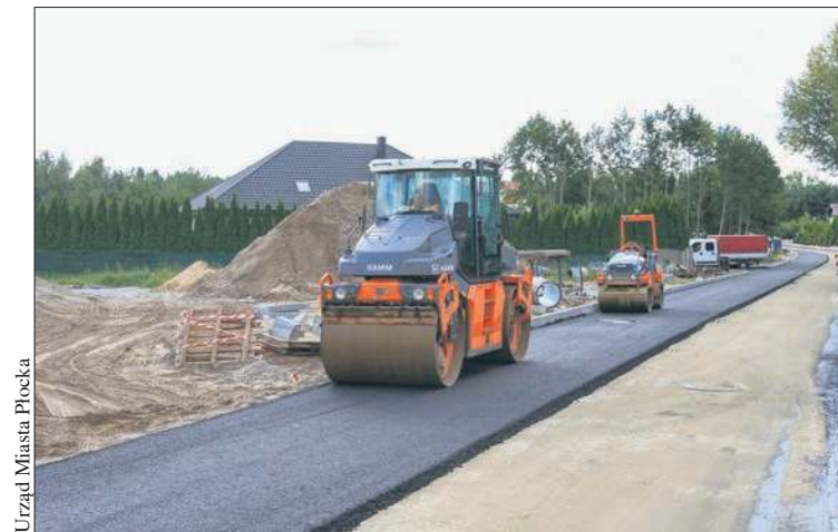
Trwa przebudowa ulicy Browarnej
