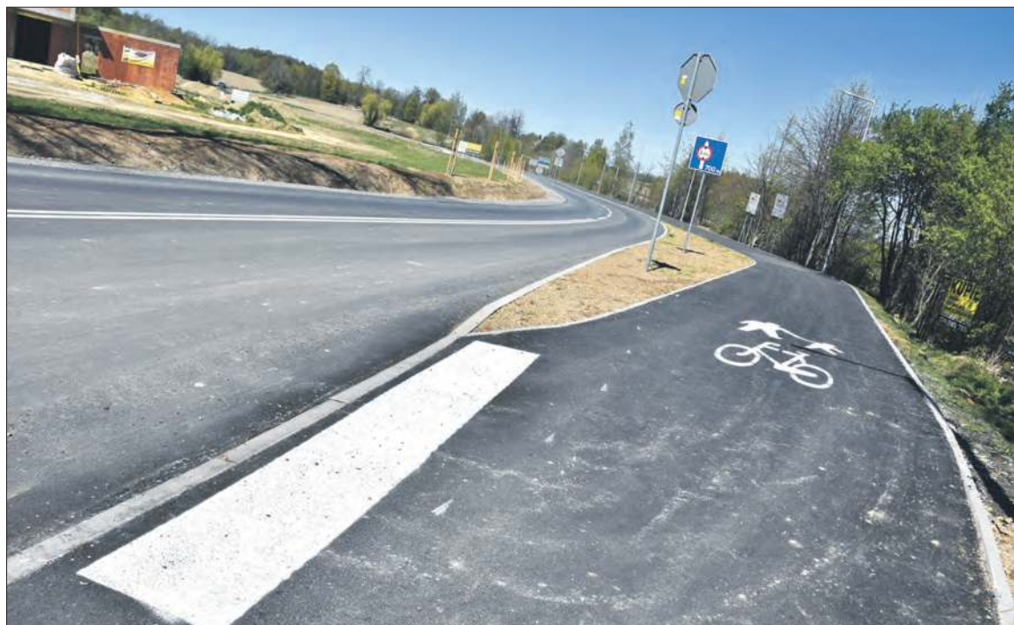
Nowy odcinek drogi od strony Pokrzywnej
