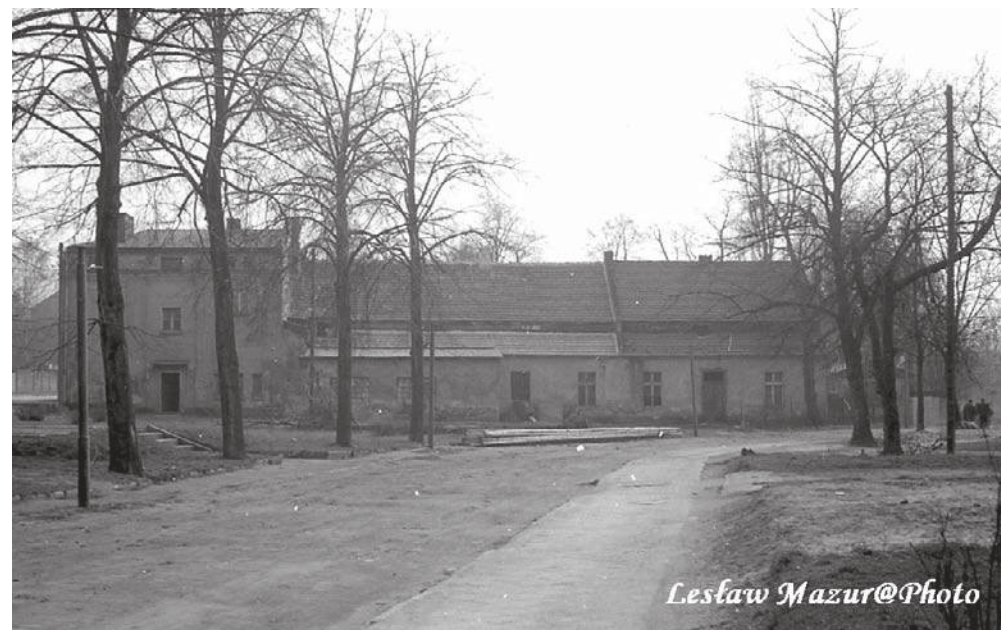
1970 - zdjęcie zrobione od ul. Spacerowej, po lewej zabudowania związane z Zakładami Mechanicznymi PZGS. Zwracam uwagę na nawierzchnię ulicy Spacerowej, była z żużlu. Do stacji szło się ścieżką przy płocie Zakładów Mechanicznych PZGS, ale o tym napiszę przy okazji. W prawo, pomiędzy stawami, potem pod mostem kolejowym przez drewniany wówczas most na rzece Oława, zwany „krowim”, droga biegła do Jaczkowic. Dziś miasto planuje tu wybudować drogę na osiedle domów Nowy Otok, aby odciążyć przejazd kolejowy na ul. Wiejskiej
