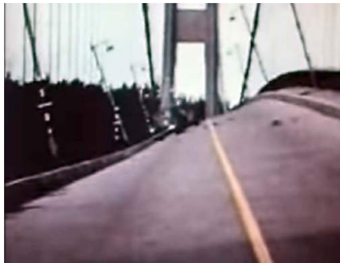
Fotografia 1. Most na w miejscowości Tacoma (USA) w stanie rezonansu
