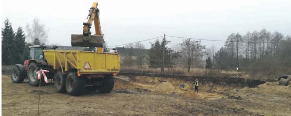
Prace ziemne w Janikowie już trwają
