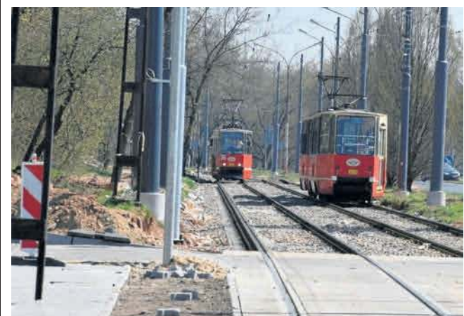
Dąbrowa Górnicza: trwa remont torowiska tramwajowego w Gołonogu
