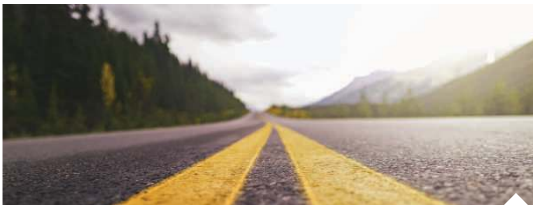
Koło Rzeszowa rozpoczęto realizację odcinka Via Carpatii. Wartość inwestycji to ponad 2,2 mld zł, a jej ukończenie zaplanowano na 2026 r. | fot. Pixabay/d
