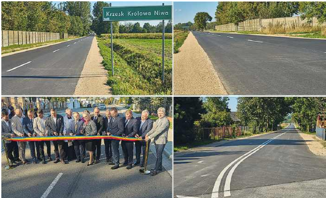
Rozbudowa drogi powiatowej nr 3667W była jedną z ważniejszych inwestycji drogowych Powiatu Siedleckiego w ostatnich latach.
