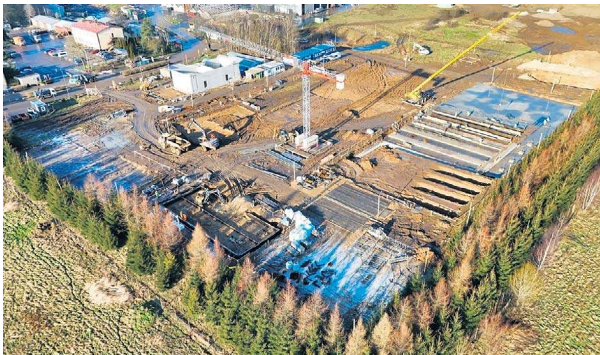
Przy budowie instalacji do suchej fermentacji odpadów obecnie trwają prace ziemne
