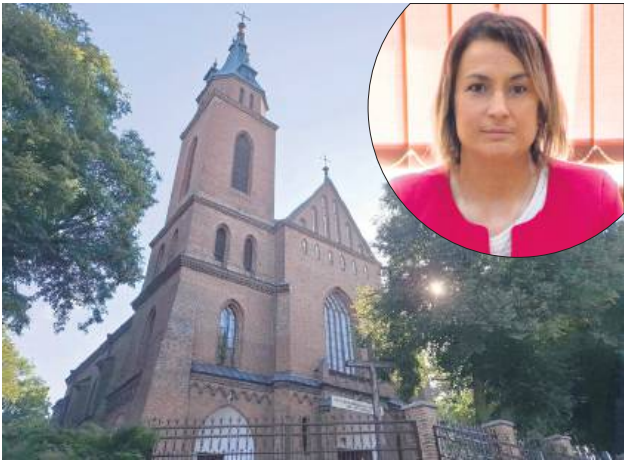
Przykościelna dzwonnica, schody do świątyni oraz część ogrodzenia wyremontowano z prawie półrocznym wyprzedzeniem. Teraz nad dokumentacją inwestycji pochylają się śledczy z Hrubieszowa.
