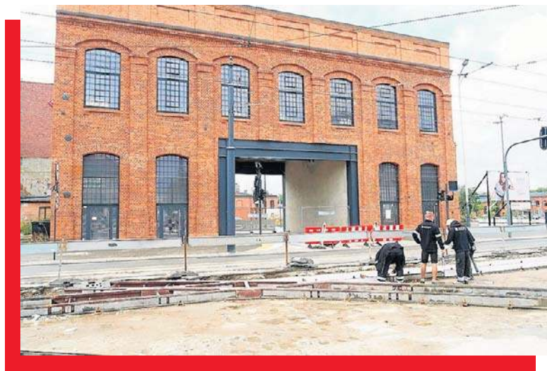
Brama wjazdowa w nową ulicę nazwaną przez mieszkańców miasta łódzkim łukiem triumfalnym jest gotowa. Prace przy torowisku jeszcze potrwa...
