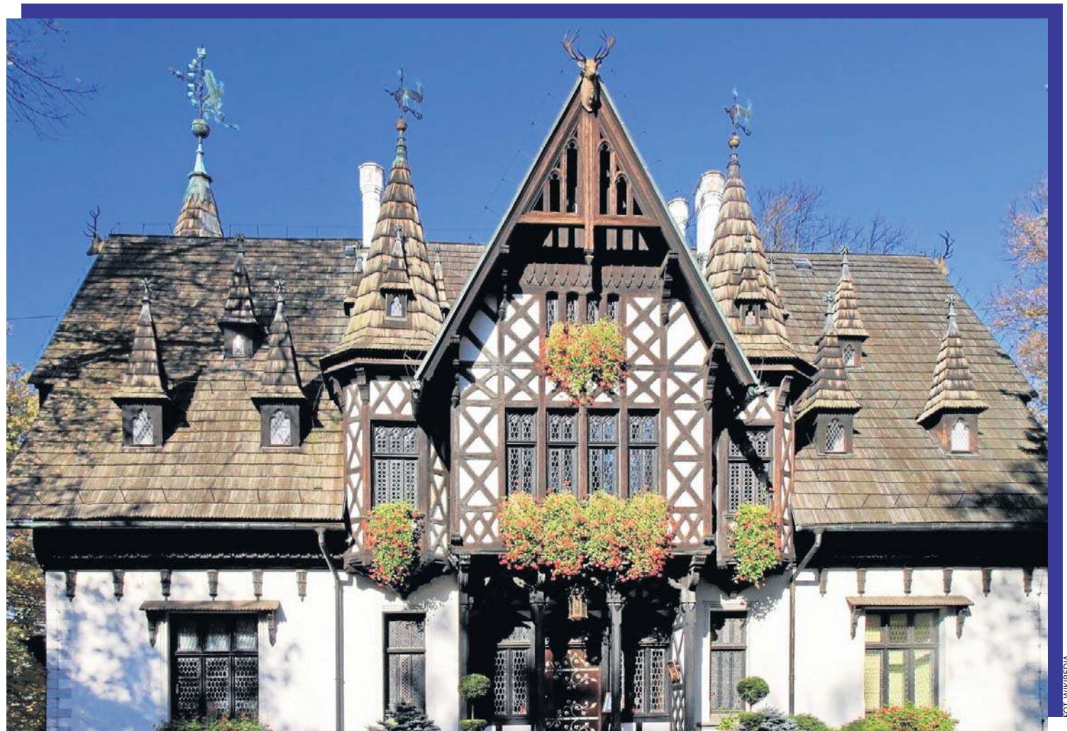
Zameczek myśliwski w Promnicach przeszedł gruntowną rewitalizację, która trwała prawie osiem lat.
