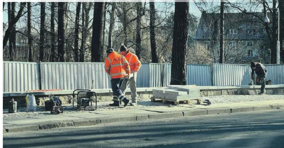
Układają na murku płyty
