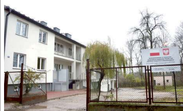
W ostatnich miesiącach obiekt przeszedł kompleksową termomodernizację
