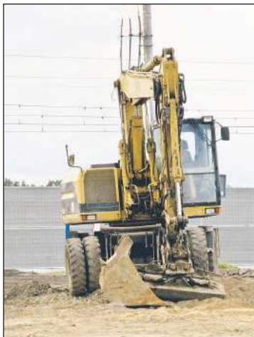
Koparki na plac budowy powinny wjechać w połowie marca.
