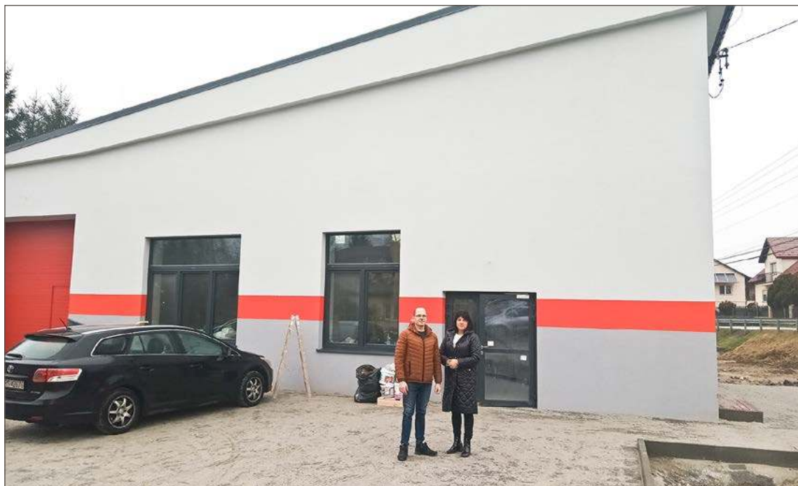
Sołtyska Halina Kuszowska i pracownik UG, radny powiatowy Adam Kaczor oglądali budynek tuż przed zakończeniem robót.
