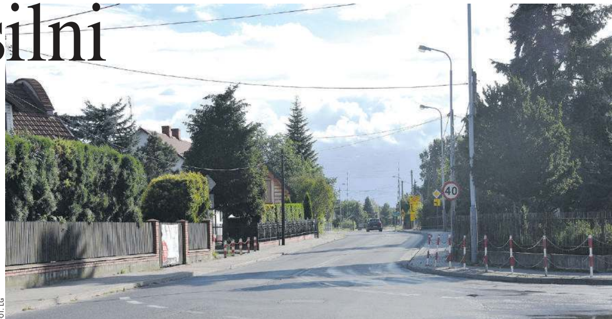
Mieszkańcy ulicy Głowackiego, szczególnie odcinka od centrum miasta do torów, boją się, że po przebudowie drogi wojewódzkiej tiry będą przejeżdżać tuż pod ich oknami
